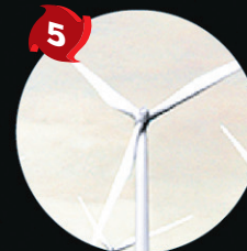
5 Turbina de 5MW
